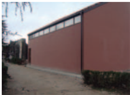
Edificio "auxiliar" gruta
